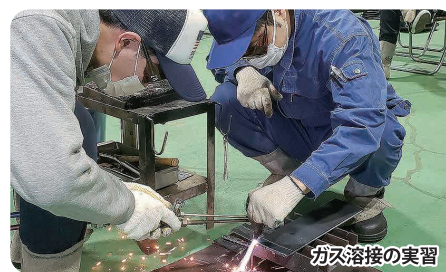
ガス溶接の実習
